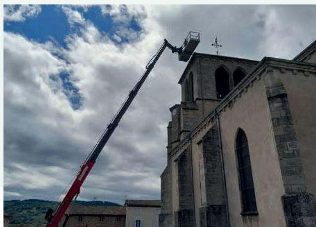
Toit de l'église de Marat
